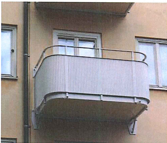
22. På en del byggnader har balkongerna utförts med täta balkongfronter.
