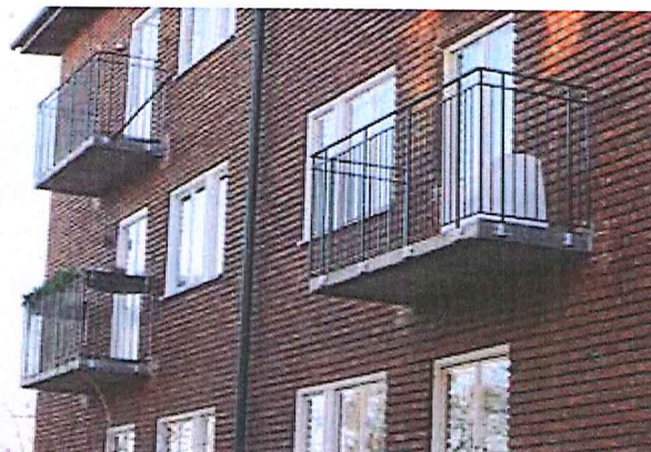
20. Nya balkonger med smäckra pinnräcken och balkongplattor i ofärgad betong ingjutna i fasaden och bjälklaget, Hjorthagen
