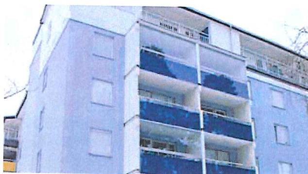
32. Husby, balkonger efter renovering där balkongfronter byttes ut mot nya i färgat glas....
