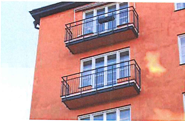
27. Exempel på nya balkonger med 1,0 meters djup.
