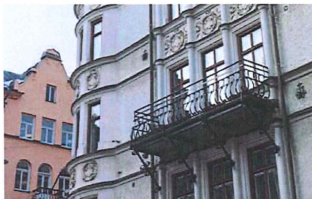
37. Bostadshus från 1890- tal med endast en balkong på fasad mot gata, Östermalm
