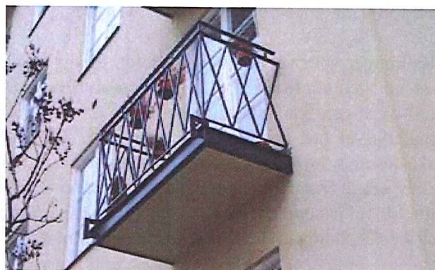
12. Ny balkong lika ursprunglig, Kungsholmen
