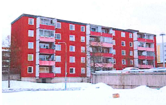
42. Indragna balkonger med fronter av korrugerad kulört plåt.
