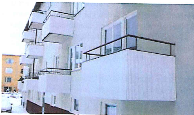
30. Exempel på väl underhållna balkonger, Årsta
