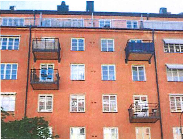
26. Exempel på en fasad mot gata där samtliga balkonger i dagsläget inte har uppförts.
