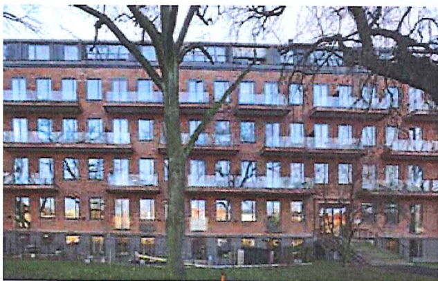
14. Institutionsbyggnad i Vasaparken ombyggd till bostäder med nya balkonger i tegel och glas.
