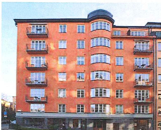
11. Exempel på nya balkonger med ett djup på 1,0 meter som placerats två våningar ovanför bottenvåningen, Kungsholmen.
