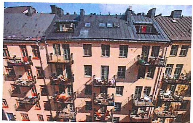
9. Innergård med nya balkonger, Vasastaden.
