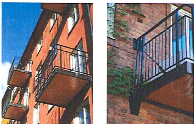
18., 19. Lättbalkonger med blanka undersidor av plåt och synliga dragstag, infästningsplattor och svartmålad pinnräcken.
