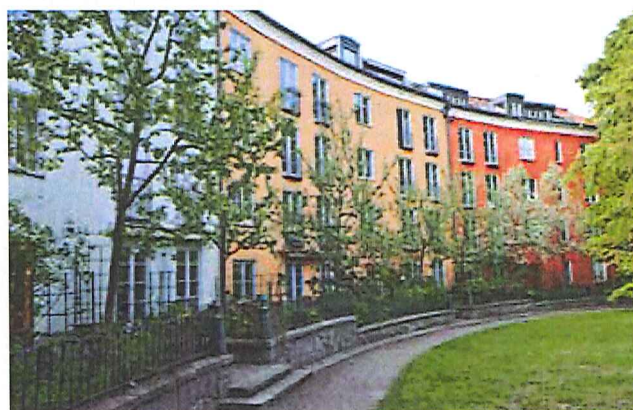
7. Innergård med franska balkonger, Kungsholmen
